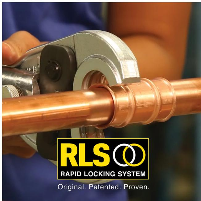
RLSは専用の電動ツールで圧着するだけで
